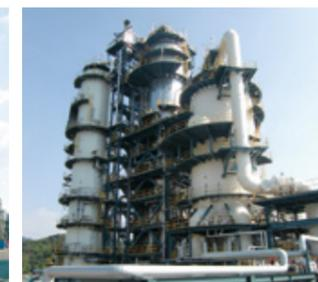
**残油流動接触分解装置**
