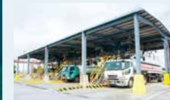
石油製品は、陸上出荷設備にてタンクローリーに積み込まれ、本島各地への安定供給をしております。
