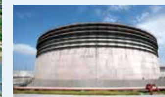
石油製品を貯蔵する大型タンクを所有し、沖縄県全域の需要に十分に対応できる量の石油製品を保管することが可能です。
