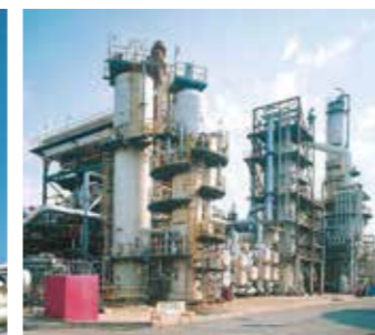
水素化分解装置 減圧蒸留装置で残渣油から分離された減圧軽油を、水素ガスと混合し、高温高圧雰囲気中で触媒と反応させ、高品質のナフサ・灯油・軽油を製造します。
