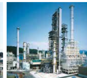
BTX設備 原料であるナフサに水素化処理や接触改質処理を行い、得られた改質油を蒸留・抽出、トランスアルキル化することで、ベンゼン・キシレンを製造します。
