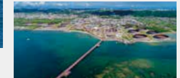
南西石油株式会社(沖縄県西原町) 同社のターミナルを経由し、沖縄県内に石油製品を供給しています。
