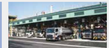
四国事業所 陸上出荷設備
